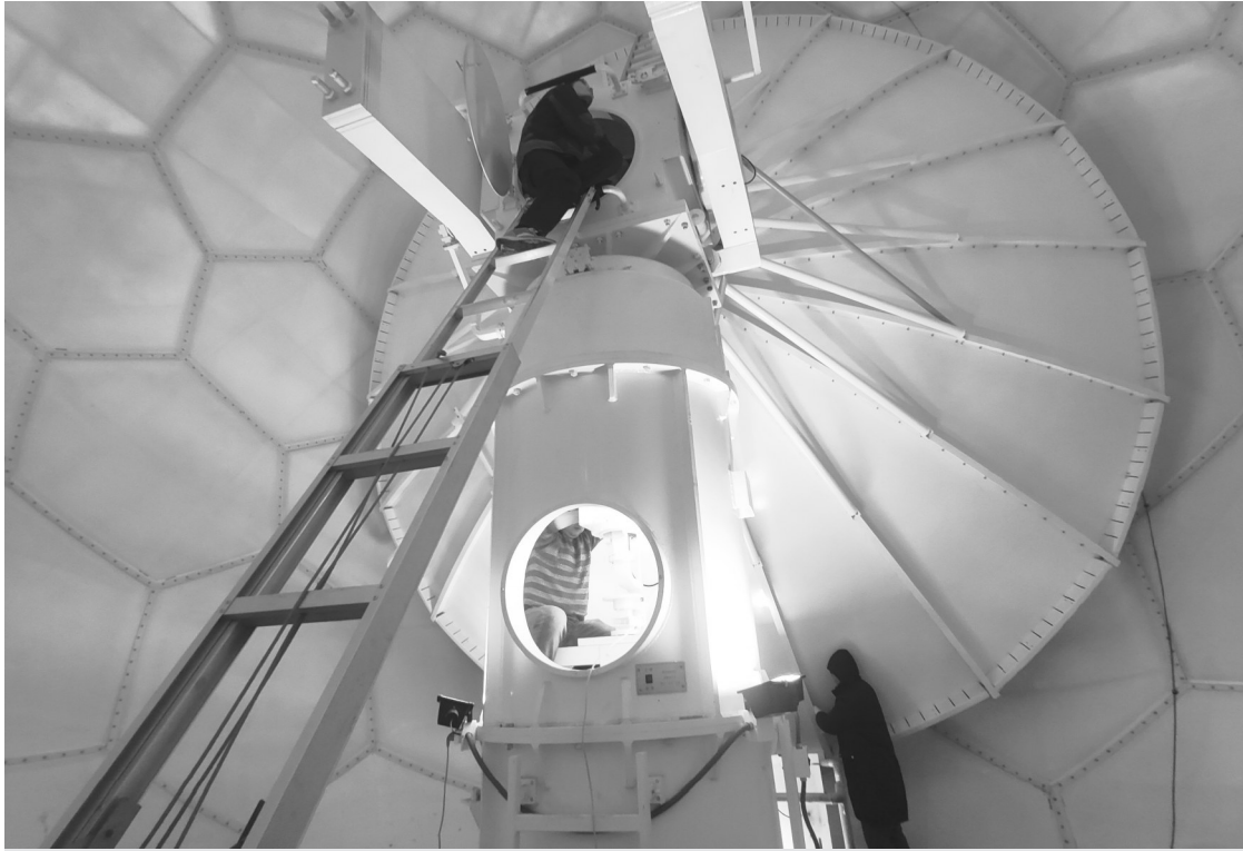
为在汛期提供及时、可靠的气象监测产品，2月28日至3月3日，江苏省探测中心和北京数视达雷达有限公司技术人员对宿迁市天气雷达开展巡检，并形成完整测试报告。图/文 唐欢
